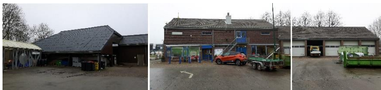
Buurtstroom Bunnik aan de Rumpsterweg
